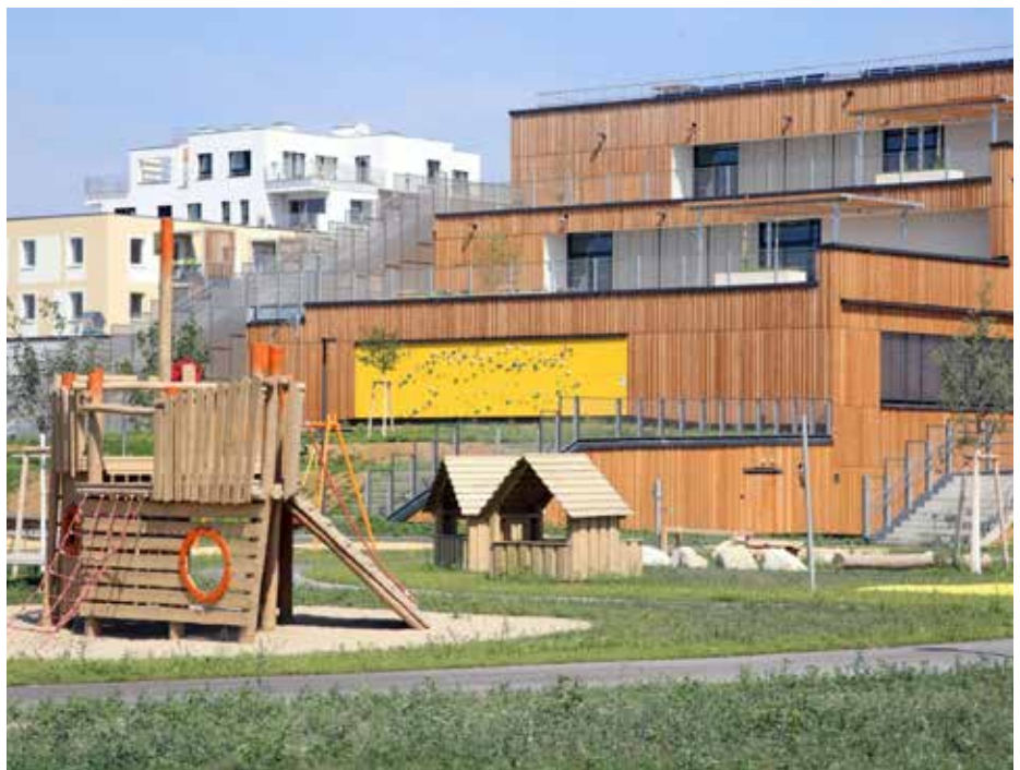
Neue "alte" Baumaterialien, hier am Bildungscampus Aspern, sorgen für neue architektonische Ästhetik.
