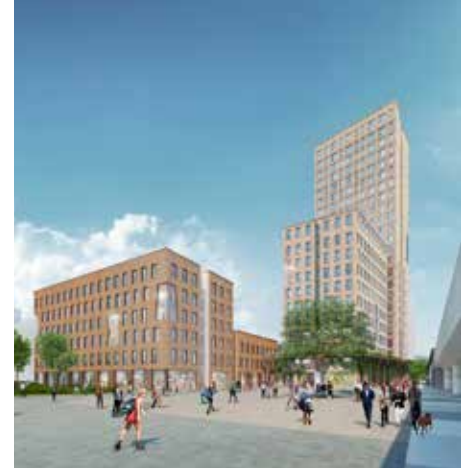
Das HoHo Wien in der Seestadt punktet mit seiner Lage direkt an der U2. FOTO: BAUDEVELOPMENT-GMBH_RÜDIGER-LAINER-U-PARTNER-ARCHITEKTEN-ZT
